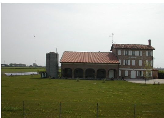
I pannelli fotovoltaici rispetto all'agriturismo
