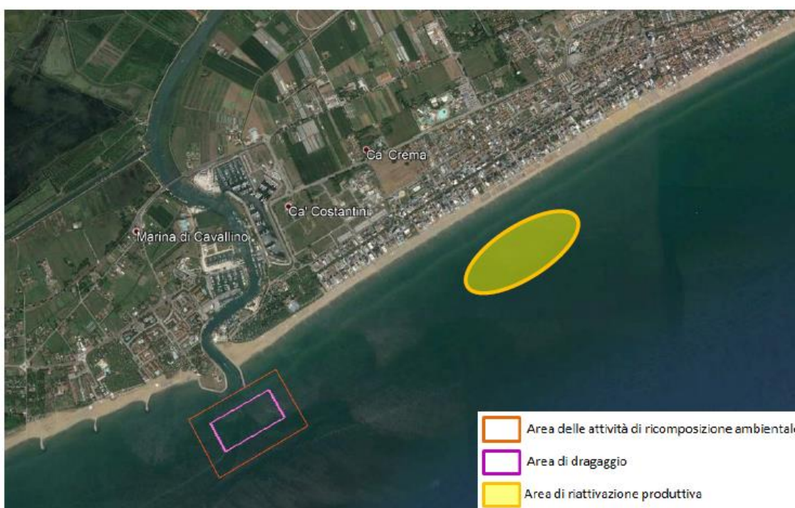
Figura 9.4: Inquadramento dell'area di realizzazione delle attività.
