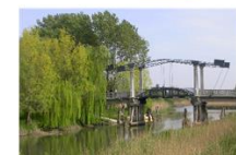
Ponte a bilanciere a Portegrandi
