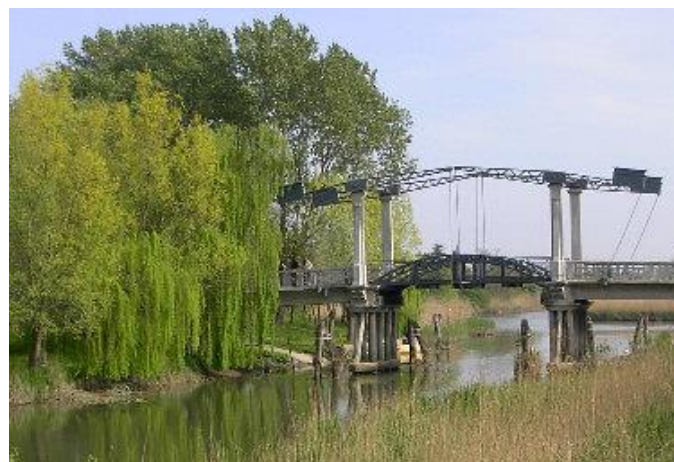
Ponte a bilanciere a Portegrandi
