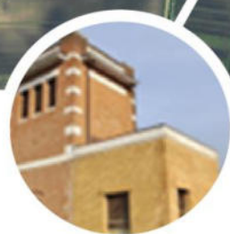
Impianto idrovoro Lison 2
