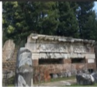
Un cantiere ecosostenibile alla Basilica Emilia. Il restauro degli elementi architettonici
