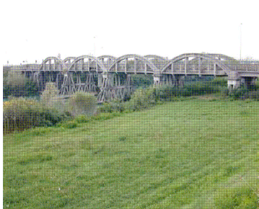
Vecchio ponte sul Fiume Livenza accanto alla S.S. n°14
