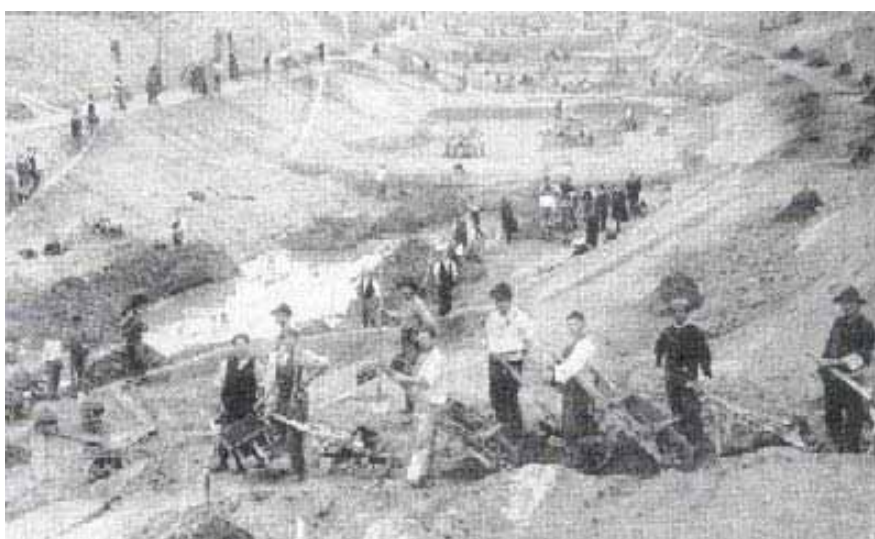
Figura 21 Badilanti impiegato nelle opere di bonifica
