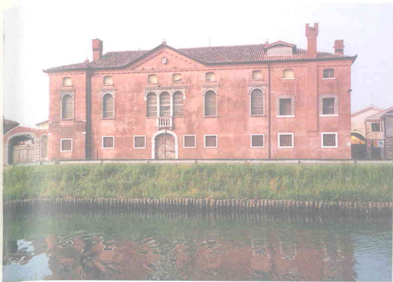
Villa Soranzo, fronte nord sul Lemene.
