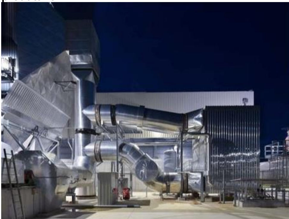
Un'immagine della Zignago SpA di Fossalta di Portogruaro che fa parte della documentazione fotografica del progetto Masterplan delle aree produttive.
