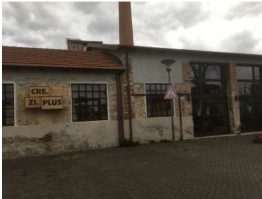
Serre dei giardini Margherita, BO http://leserre.kilowatt.bo.it/
