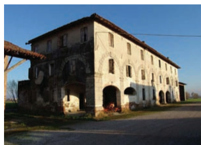
Vista esterna: prospetto sud-ovest
