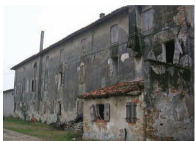
Vista esterna: prospetto nord
