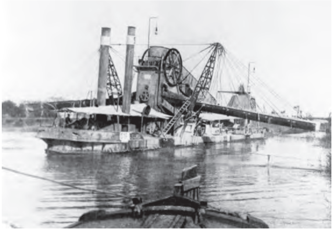
La grande draga per lo scavo dei canali
